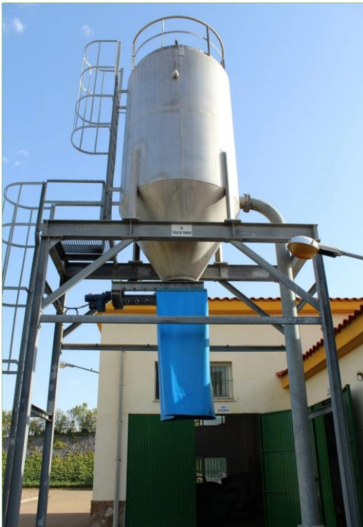
Tolva de lodos deshidratados de EDARU Aceuchal (BA)
